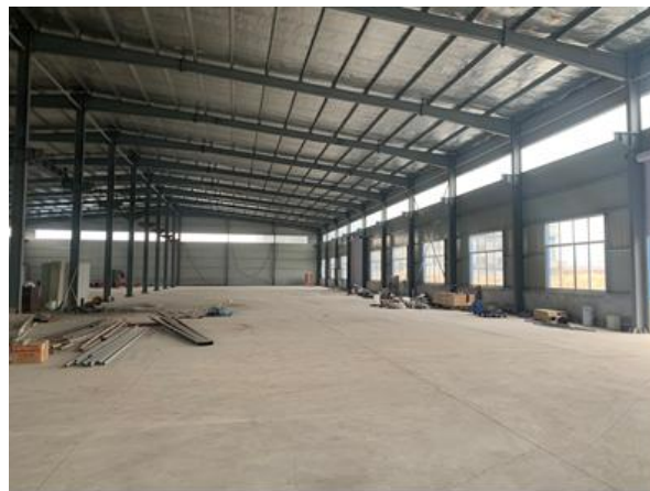
生产车间现状
