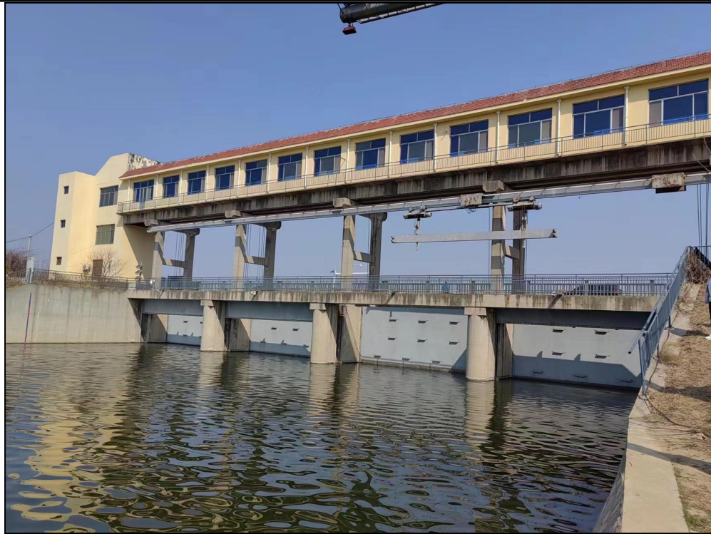
图 3-1 入河闸现状照片
