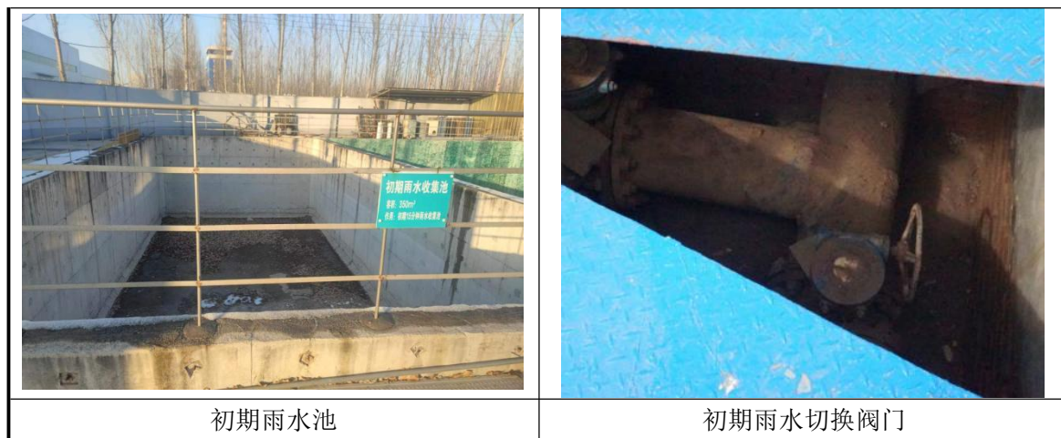
图 6.1-1 厂区现有风险防范措施图
