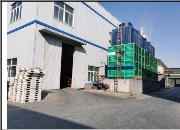
蒸发离心车间和循环水池
