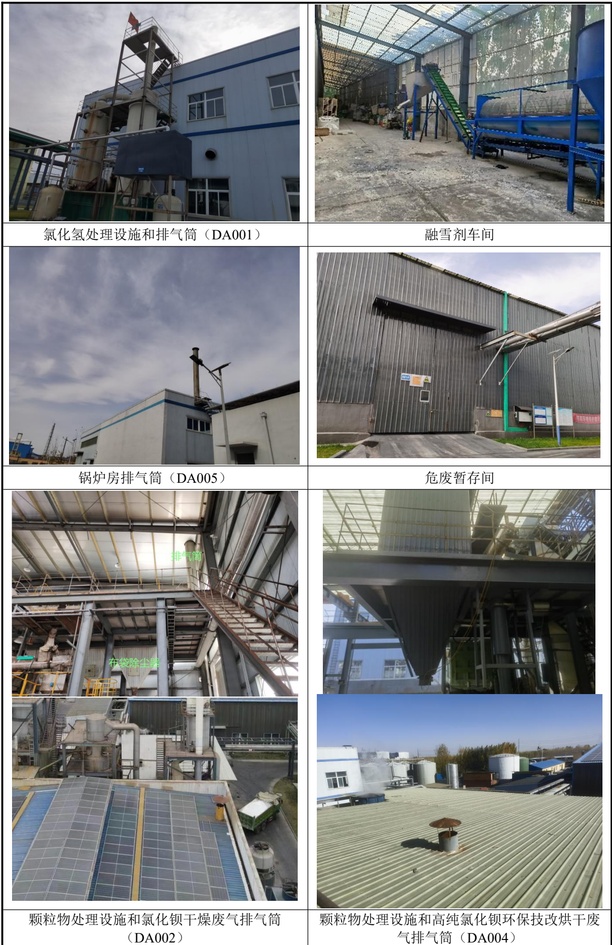
图 2.2-2 厂区现状照片
